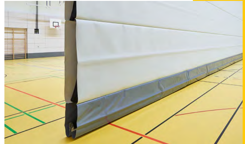
Trennvorrichtungen zur Teilung der Sporthalle, Sportpark Freiam, München
