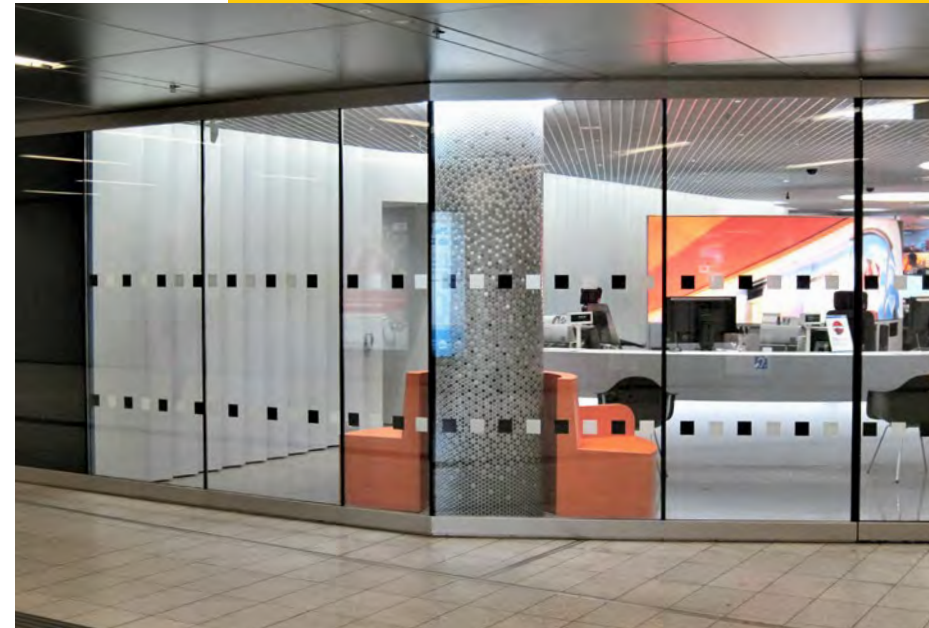
Sicherheitsmarkierungen an Glaswänden, Marienplatz Sperrengeschoß, München
