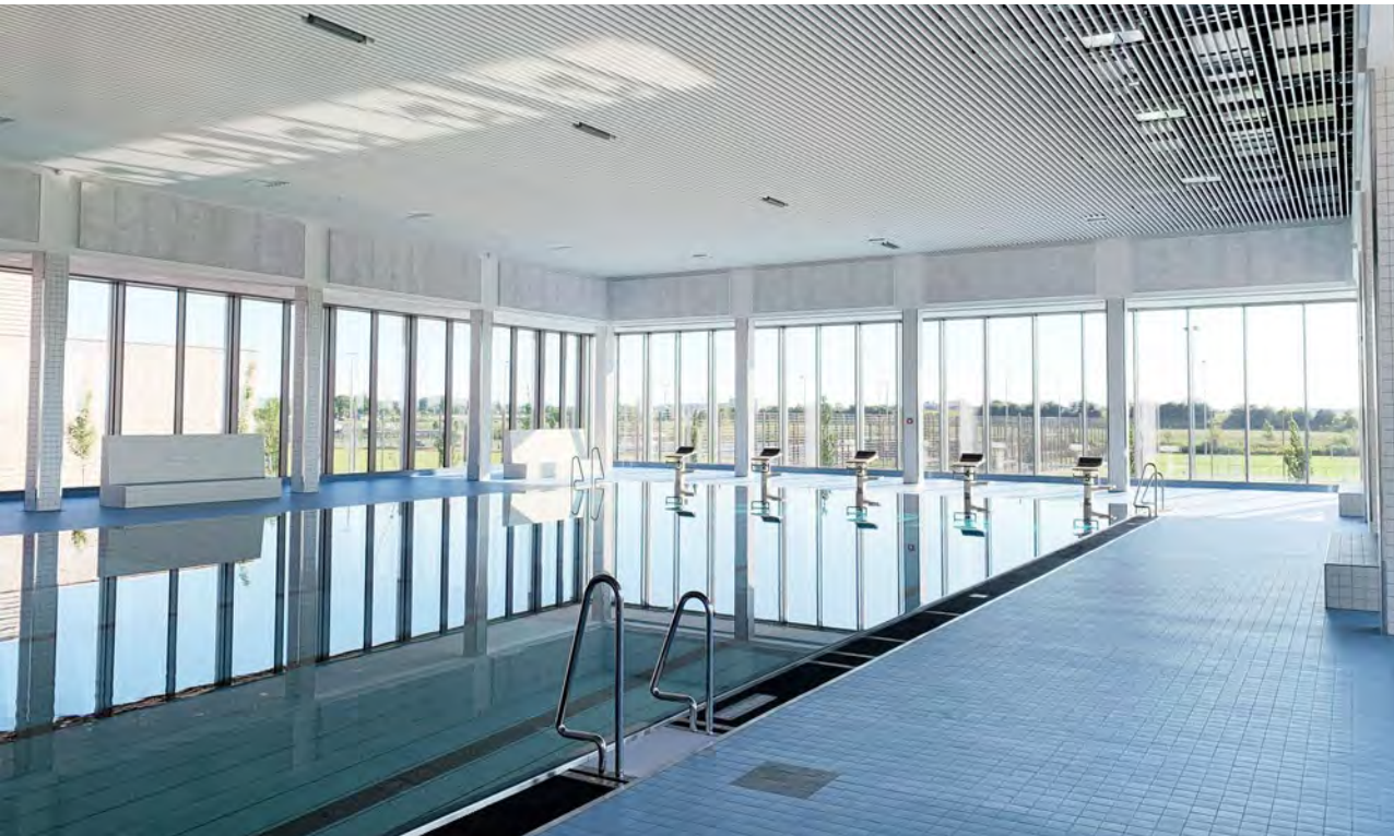
Schwimmhalle, Sportpark Freiham, München
