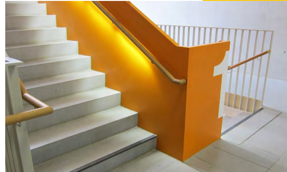
Kontrastreiche Gestaltung eines Treppenhauses, Gymnasium Trudering, München
