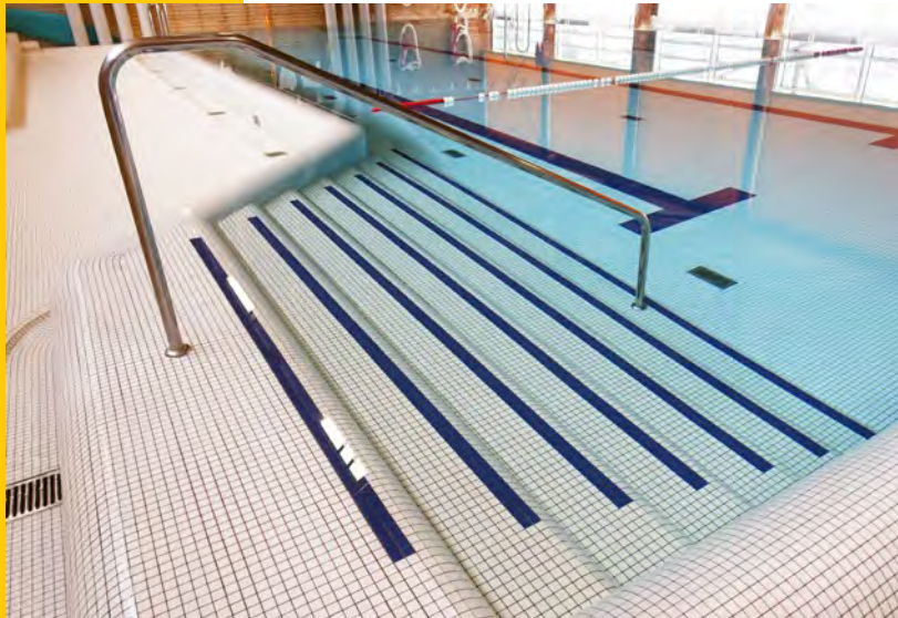
Kontrastreiche Gestaltung im Schwimmbeckenbereich, Edith-Stein-Realschule, Sehbehinderten- und Blindenzentrum Südbayern, Unterschleißheim
