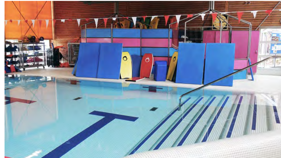
Markierung des Beckenendes mit Fähnchen, Edith-Stein-Realschule, Sehbehinderten- und Blindenzentrum Südbayern, Unterschleißheim
